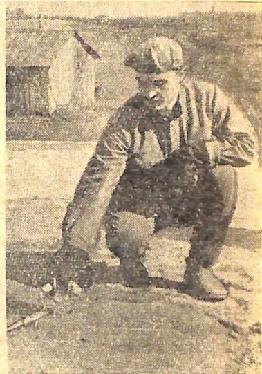
В. Лісовий на кладці покрівлі корівника.
