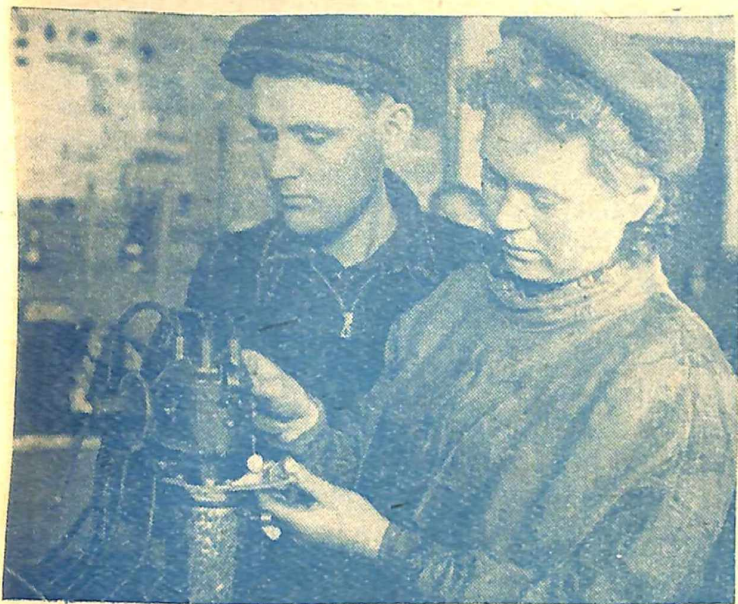
На фото: майстер електроцеху М. Черевко допомагає студентці В. Лінню у випробуванні розподільючих точок двигуна.
