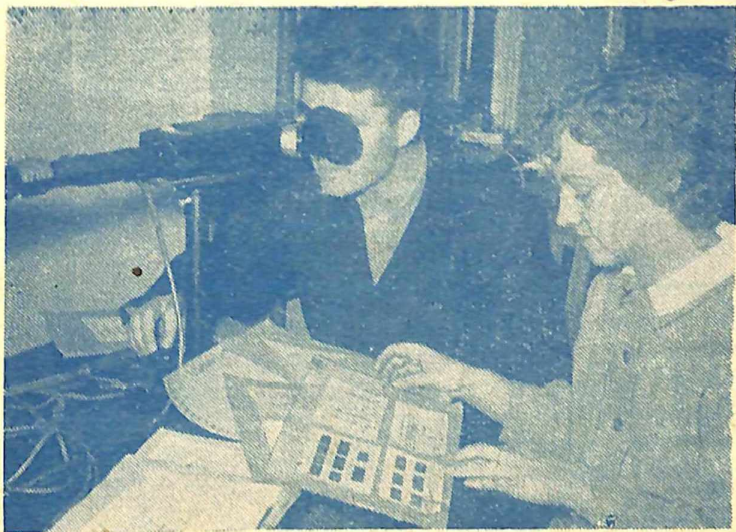
У одному з кабінетів кафедри фізики. Студенти за роботою. Аналіз сплавів при допомозі стилоскопа.
