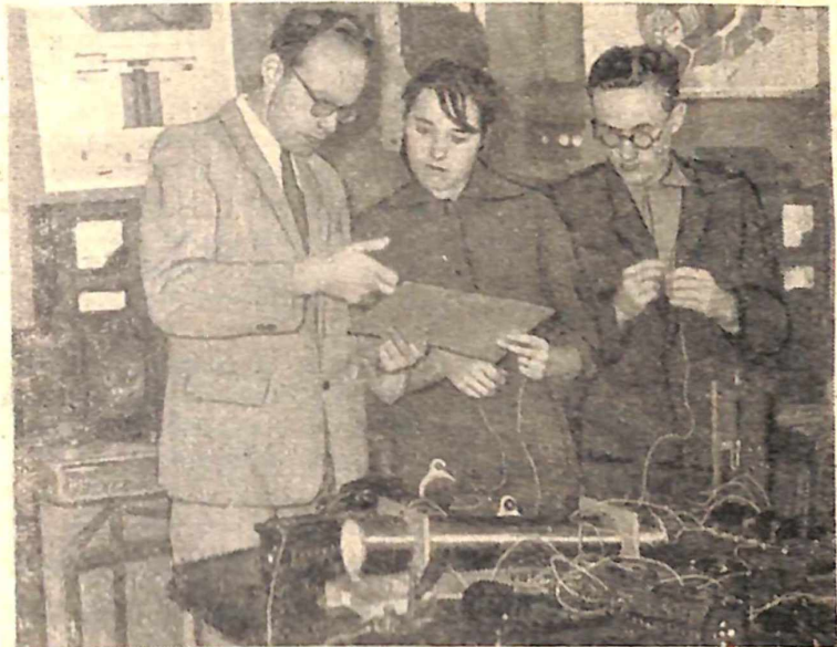
Багато роботи тепер у третьокурсників 31 групи фізиків. Під керівництвом свого викладача О. Войцехівського вони проводять практичні заняття з найбільш складних питань фізики. На фото: студенти опрацьовують тему «Визначення відношення заряду електрона до його маси за методом магнетрона».
